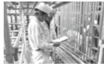
監督員と現場代理人による 施工状況把握▶P.5
