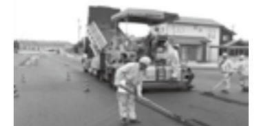
朝日建設(株) 第一工事事部 小松 良介さん アスファルトフィニッシャーを 運転している写真▶P.15
